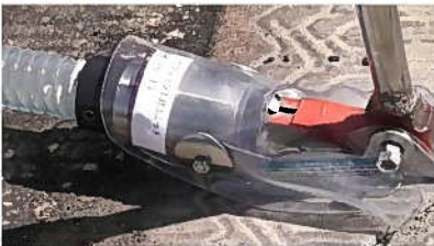
石綿スレート 撤去作業の様子
