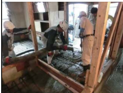
基礎補強「鉄筋・コンクリート打設」
