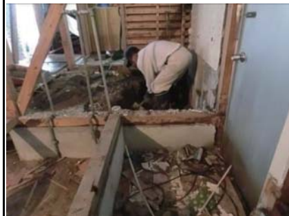
人力解体「屋内」
