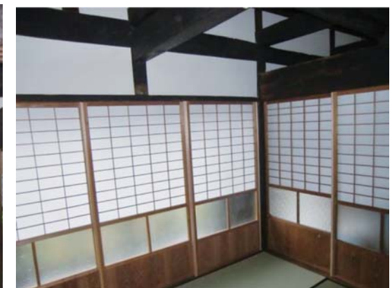
⑦.和室(木製建具 再利用)
