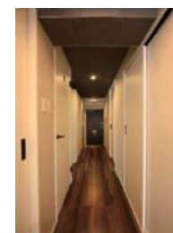
▲②玄関・ホール 天井に100カットタイル、玄関収納上部にスリットを設け調湿・空調に配慮
