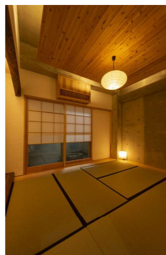
打ち放しの天井の約40cm下に木板の吊天井を設置し、コンクリートの打ち放しの壁と木材を違和感なく仕上げることが出来ました
