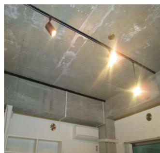
打ち放しの天井
