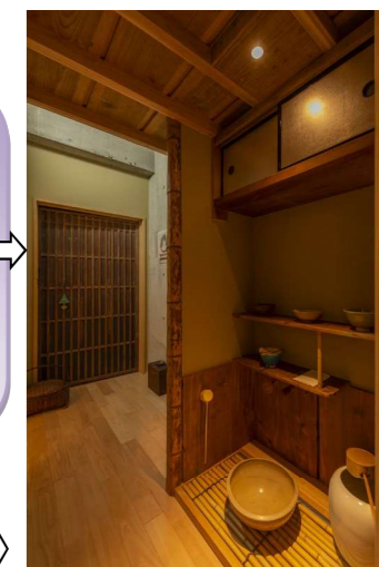
水屋の天井、天袋の敷居、鴨居、棚竹、腰壁は古材で仕上げました
