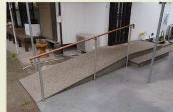
▲室内の段差解消のため、あえて高さを上げた玄関ドアまでのアプローチは、スロープにて段差を緩和。表面の仕上げは、豆砂利の洗い出しなので滑り止め効果も期待できる。
