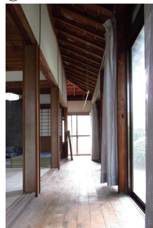
③ 南側縁側改修前
