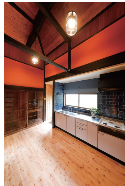
② 台所キッチンスペースを北側へ増築 天井撤去→吹き抜けとした。
