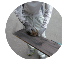
▲焼き杉板製作状況 炭落とし→磨き
