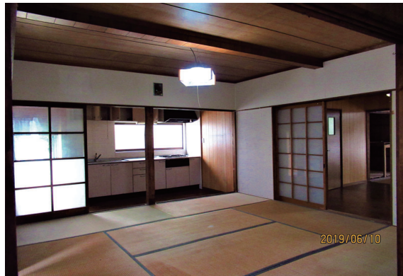
① なかえ・台所改修前(写真左)と天井裏の様子(写真右)
