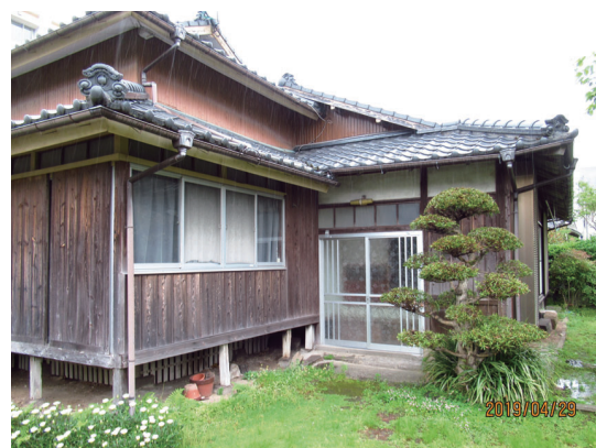
⑧ 玄関アプローチ改修前
