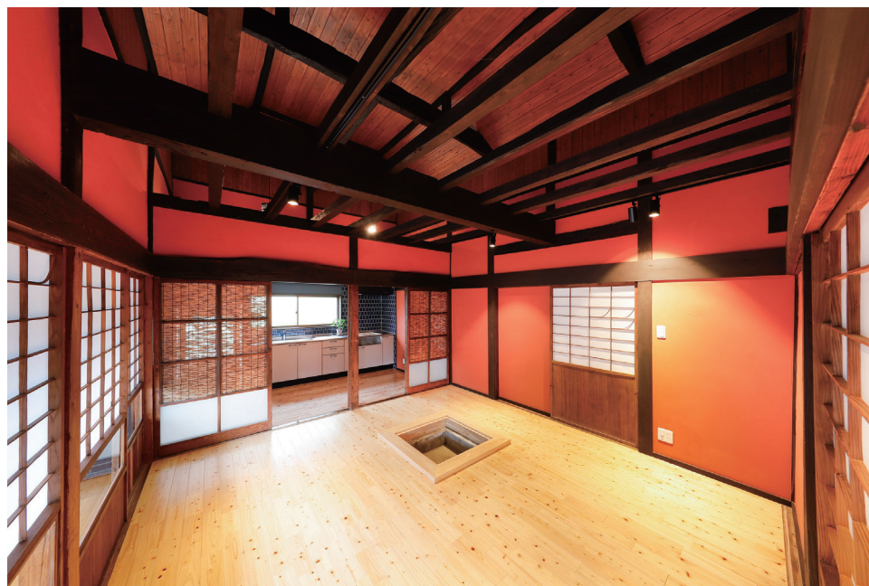
① 既存ベニヤを撤去し、台所と「なかえ」をつなげ、開放的な空間とした。壁は現存漆喰をはがし、当時のワラ入り土壁の上に珪藻土(ベンガラ)塗り壁とし、歴史を感じる内装とした。
