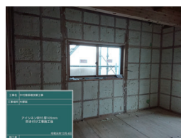
壁 断熱材 アイン吹付
