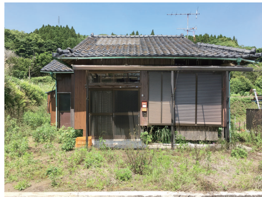
■外観(リフォーム前) 構造体残して内外装材をすべて撤去。 取り外したアルミサッシや構造材は再 利用して工事費を押さえた計画。
