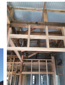
屋根・外壁にセルロースファイバーを現場吹付。サッシは全て取替。
