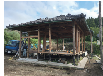
■外観(リフォーム前) 構造体残して内外装材をすべて撤去。 取り外したアルミサッシや構造材は再 利用して工事費を押さえた計画。
