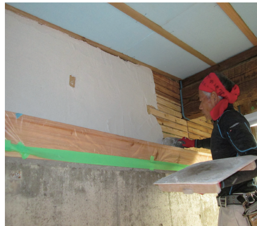
木摺漆喰工法（木摺下地）砂漆喰施工状況
