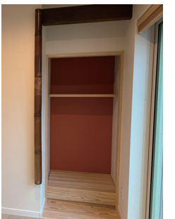
⑥仏間には、既存住宅で使われていた落とし掛けを再利用。上部棚には仏像を置きます。
