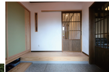
② 玄関 造作の縦格子の建具の左側には、既存の障子を一部分だけみせた洗面納戸への採光に！
