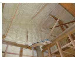
天井 断熱材 アイン吹付
