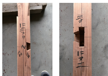
■改修工事の状況 建物の傾きや歪みを調整した後、解体し た構造材に大工が墨付けを行い手刻み による屋根架構の変更や増築を行った。
