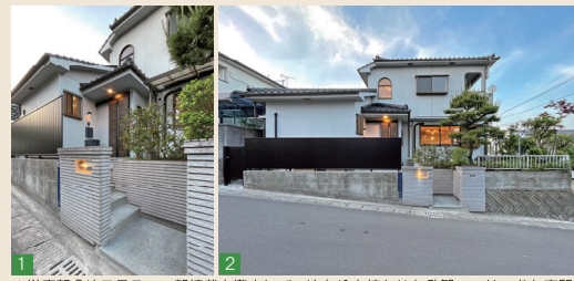
▲増床部分やテラス・一部植栽を撤去して、ゆとりを持たせた外観ファサードと玄関アプローチ。玄関アプローチの土間は、滑り止めを兼ねて、左官洗い出し仕上げに
