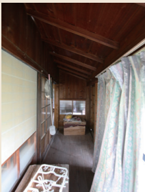
④物置となっている北側縁側
