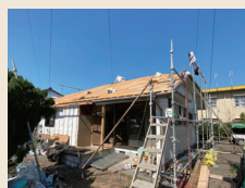
■解体状況(外観)
