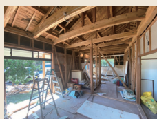
■解体状況(内観)
