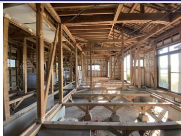
④工事途中(解体後)
