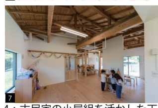
4: 古民家の小屋組を活かした天井
