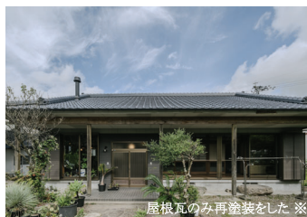
屋根瓦のみ再塗装をした ※
