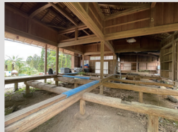
解体がほとんど終わる段階。囲炉裏の煙で燻された立派な構造材が姿を現した。
