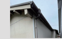
車庫に刺さっていた屋根も短く調整することで干渉を解消した。
