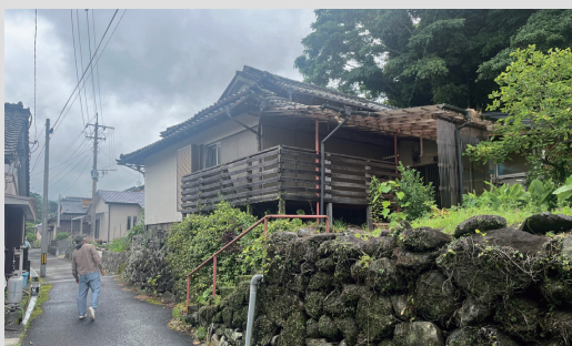
① 既存写真：道路からの見上げた外観
