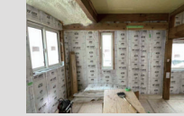
単板サッシから Low-E 複層ガラスの複合サッシに代わり断熱性が向上した。
