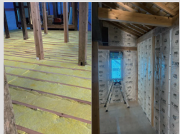
床下と壁に断熱材を施工した様子。既存は天井現しのため既存の屋根の上に重ねて、無断熱だったため大幅に断熱向上した。
