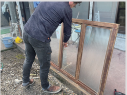
建具を洗浄しているところ。既存を再利用し、古民家の良さを最大限に活かした。
