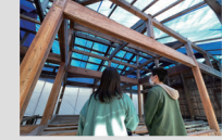
猫たち同行のお施主様の解体後確認の様子。既存状況や問題点を改めて確認。
