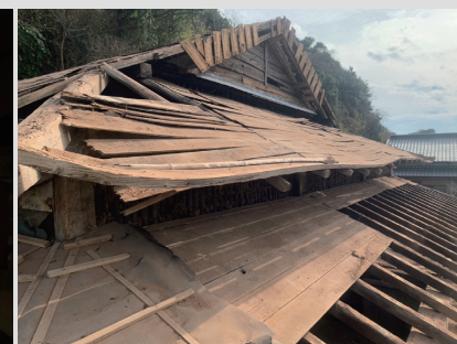
⑤ 現場写真：瓦撤去後の野地板の様子
