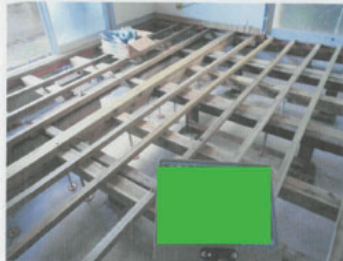
シェルターを設置するための床組補強
