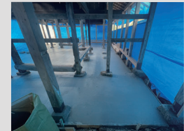
傷んだ構造材や束石の補強・取替をし、床下にコンクリートを打設している。
