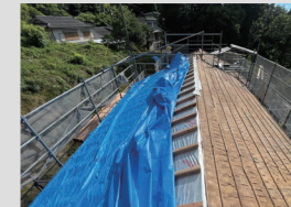
天井現しのため既存の屋根の上に重ねて、新しい屋根をつくっているところ。
