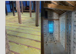
床下と壁に断熱材を施工した様子。既存は天井現しのため既存の屋根の上に重ねて、無断熱だったため大幅に断熱向上した。
