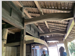
築100年の厩の構造材はとてもしっかりしており、新築にはない貫禄がある。
