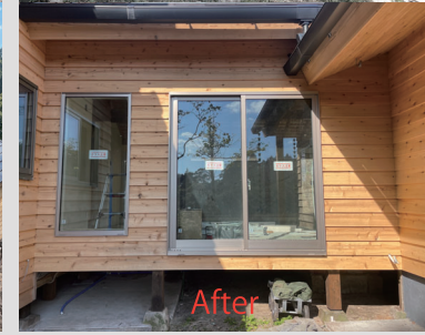
5m増築し、廐（左側）と母屋（右側）をつなげ、ひとつの建物に。
