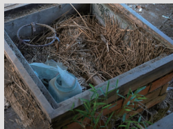
使われなくなった囲炉裏。きちんと手をいれて、再生。床材で蓋も造作した。
