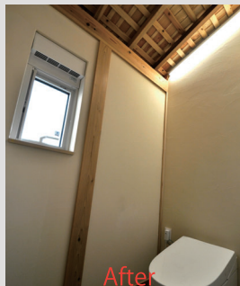
After トイレの天井も構造材現し。
