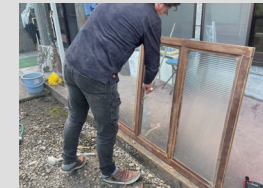
建具を洗浄しているところ。既存を再利用し、古民家の良さを最大限に活かした。
