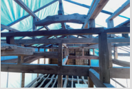
解体工事がほとんど終わって段階。古民家ならではの立派な構造材が露わに。
