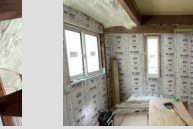
単板サッシから Low-E 複層ガラスの複合サッシに代わり断熱性が向上した。
