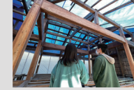
猫たち同行のお施主様の解体後確認の様子。既存状況や問題点を改めて確認。
