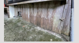
外壁木材は塗膜の経年劣化、撥水性が失われ、ヒビ割れや汚れも。
