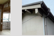
車庫に刺さっていた屋根も短く調整することで干渉を解消した。
