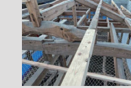
屋根の構造材の取替・補強の様子。新旧の材が繋がる様子は趣深い。
