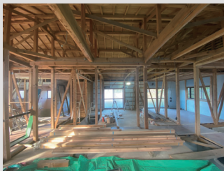
■解体撤去状況
