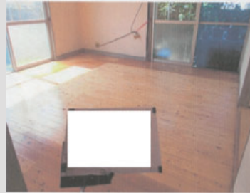
いよいよシェルター設置
